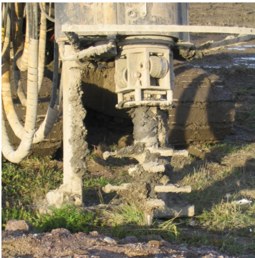
Kuva 13.a Pilarin sekoituskärki.
