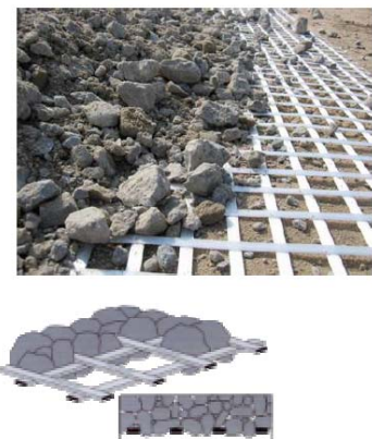
Kuva 24. Lujiteverkon lujitusmekanismi.
