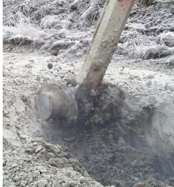
Kuva 14. Erilaisia massastabilointiratkaisuja ja massastabiloinnin sekoituskärki.
