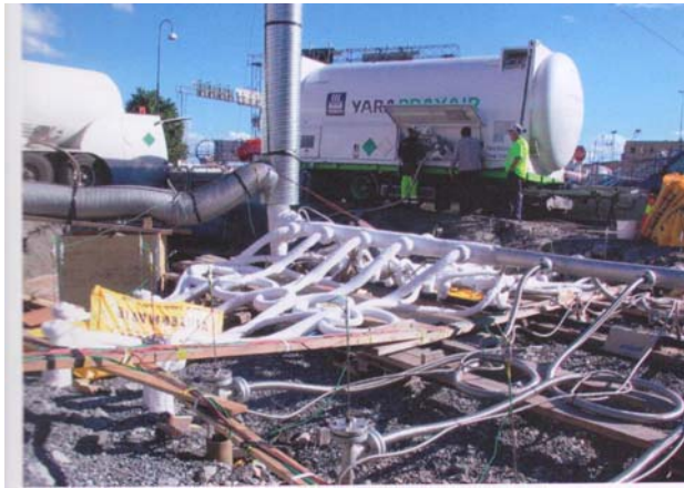
Kuva 17.a. Jääditysjärjestelmä maan pinnalla. 17 b.Södra Länken: jäädityssuunnitelma.
