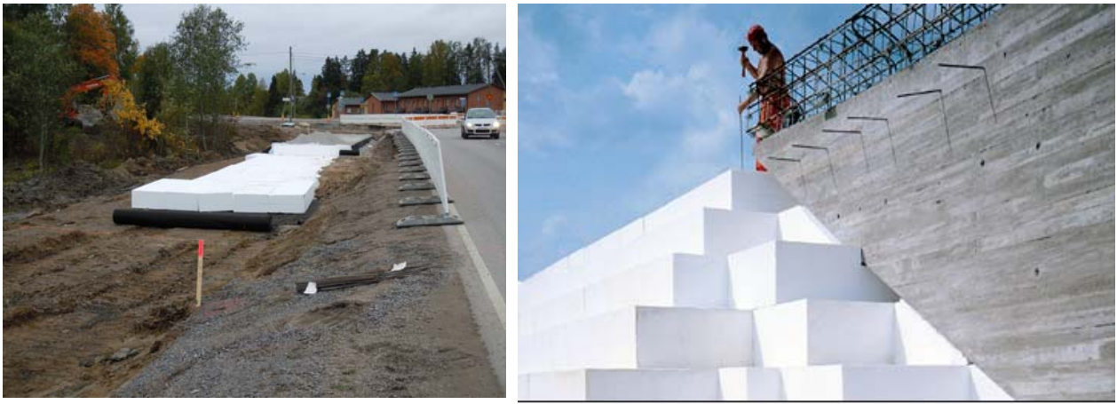
Kuva 22. Katupenkereen kevennys EPS-solumuoviblokeilla ja sillan taustan täyttöä.
